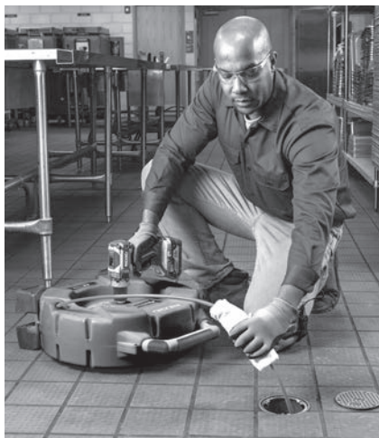
Figure 10 – Application de lubrifiant sur la gaine du câble
