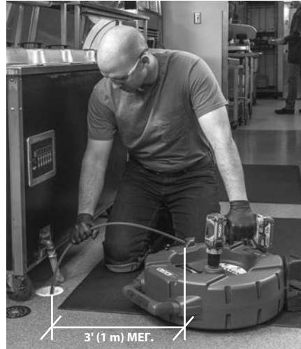
Εικόνα 8 – Σε θέση λειτουργίας
