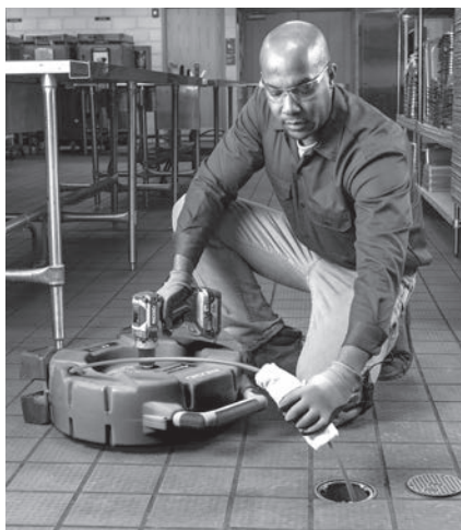
Figura 10 – Aplicación de lubricante sobre la vaina del cable
