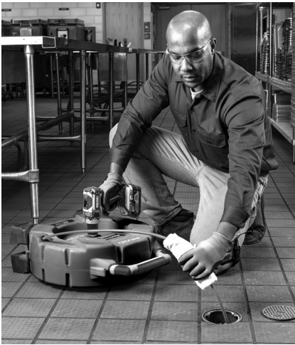
図 10 - ケーブルシースへの潤滑油の塗布
