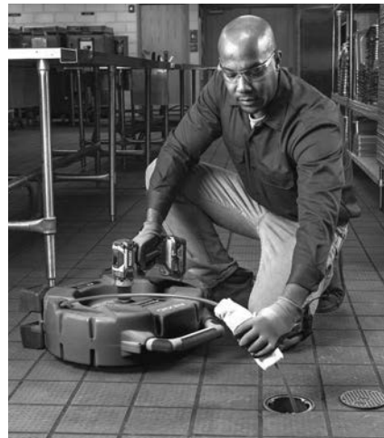
Figura 10 – Ungerea manșonului cablului
